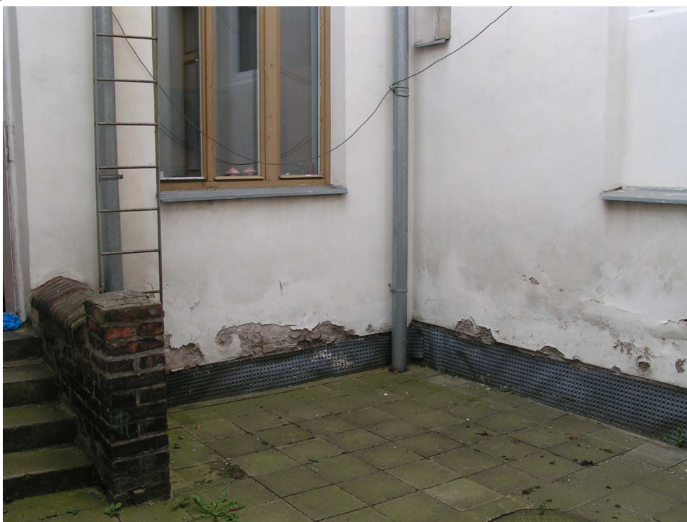
Obr. 2 – Pohled na opadanou omítku ve dvoře. Dřívější sanace nopovou fólií, která zůstala vytažená nad terén.
