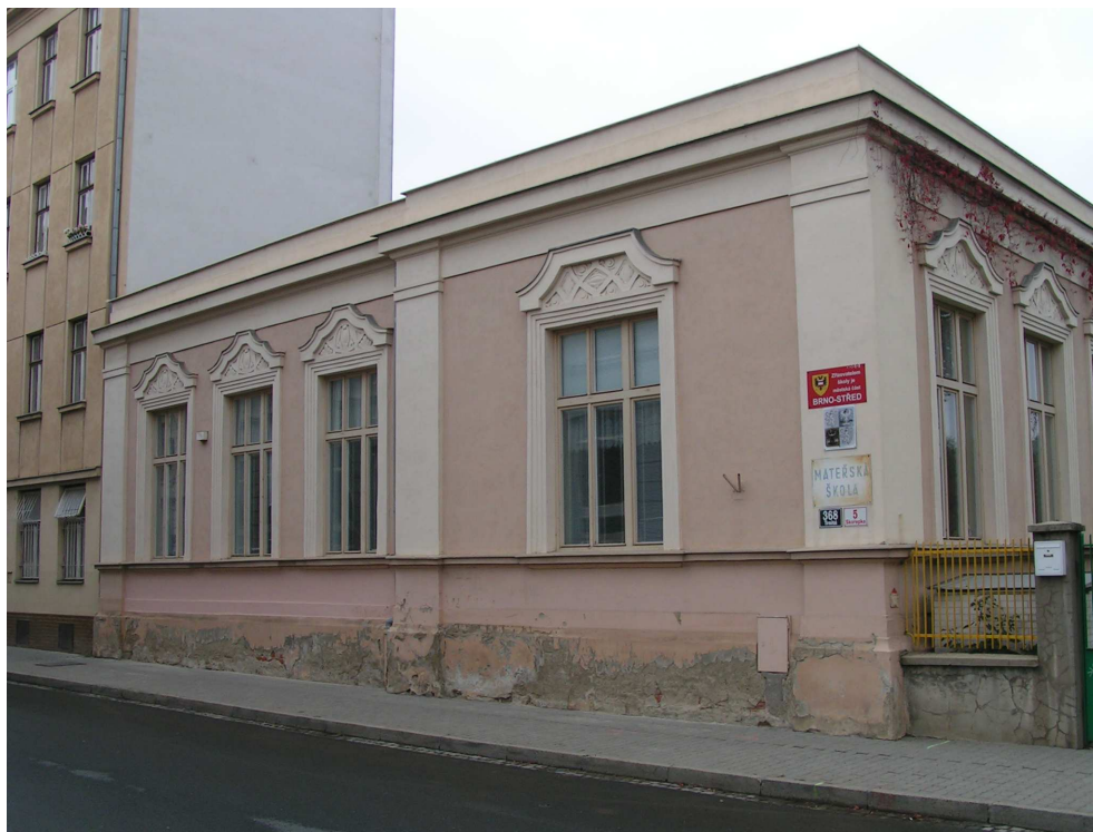
Obr. 1 – Pohled na řešený objekt MŠ z ulice Skořepka. V soklové části jsou patrné projevy vlhkosti ve zdivu – opadaná omítka, malba.
