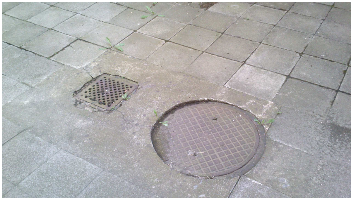
Obr. 8 – Dešťová vpusť a šachta od dešťové kanalizace procházející dvorem, do které bude svedena drenáž navržená po obvodu dvora. Vpusť, šachtu i dotčené kanalizační potrubí je nutné před napojením drenáží podrobit revizi a zhodnotit, zda je navržené řešení možné, popřípadě uskutečnit taková opatření, aby bylo napojení bezpečné.
