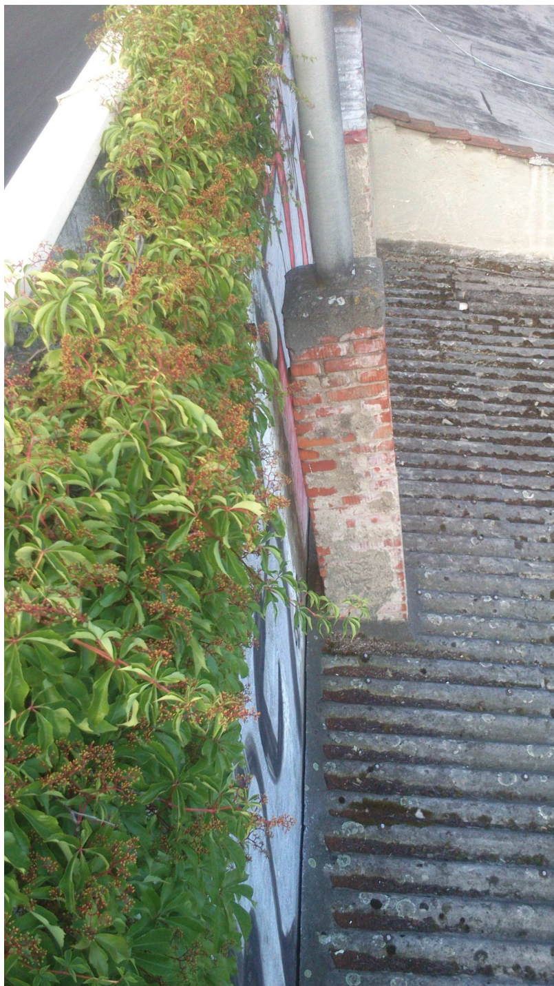
Obr. 3 – Nevhodné řešení napojení sousední střechy na objekt MŠ – úplně zde chybí klempířské prvky a vzniká tak nechráněná mezera mezi domy, kterou vniká dešťová voda do zdiva. Klempířské prvky střechy by měly být opatřeny a financovány majitelem sousedního objektu.
